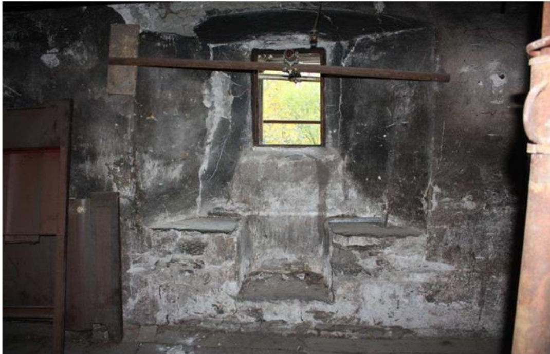
Interno corpo sud 3° livello finestra
