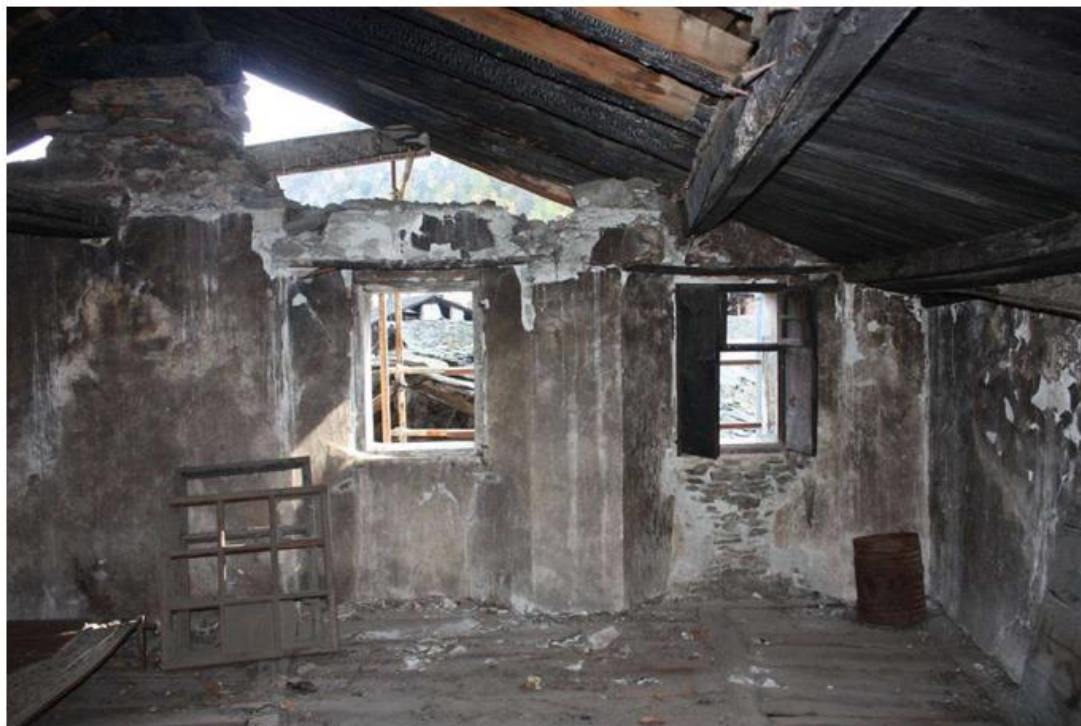
Interno corpo sud 4° livello, finestre con fasce laterali
