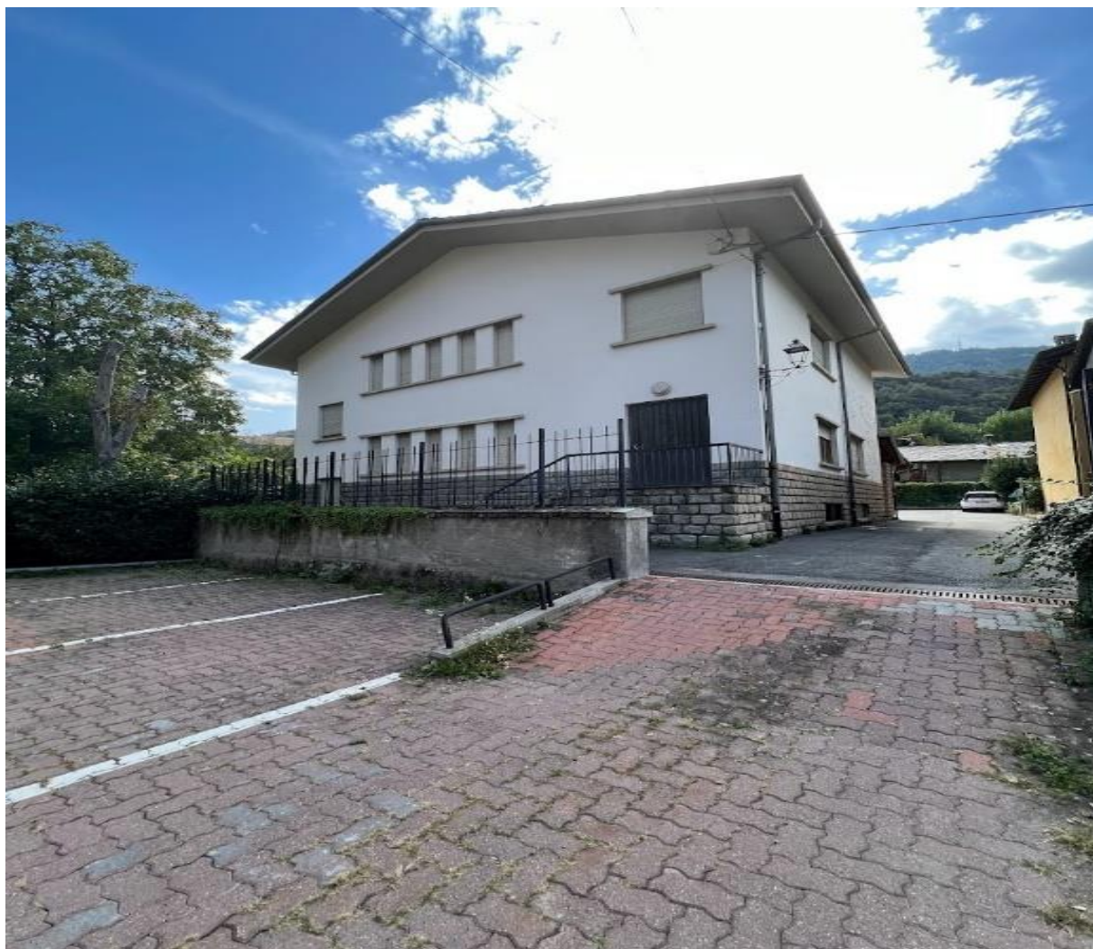
Vista del retro edificio
